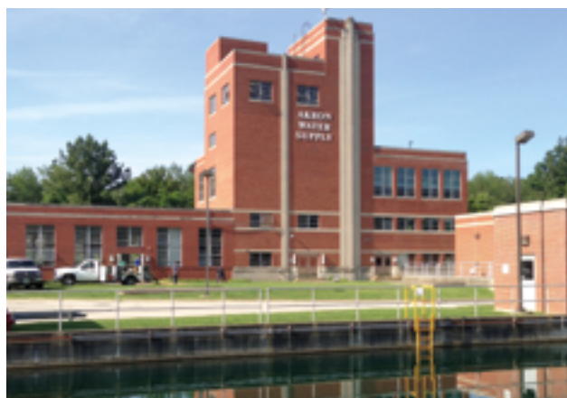
Станция очистки питьевой воды, г. Акрон, Огайо, США
